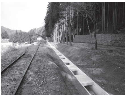
JR名松線の復旧工事（4大プロジェクト）
