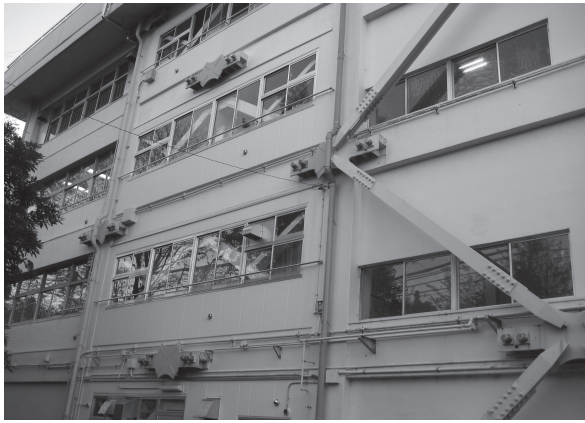
耐震補強した学校校舎
