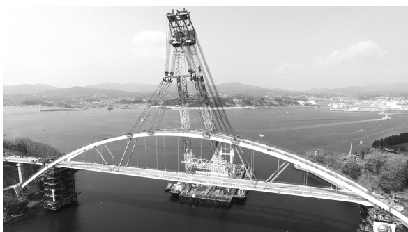
大島架橋本体架設工事
