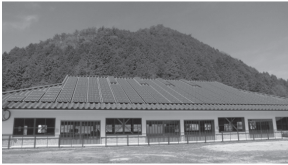
村民参加型の太陽光発電所
