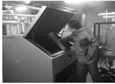
温泉施設に導入された薪ボイラー
