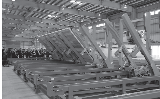
CLT工場竣工式
