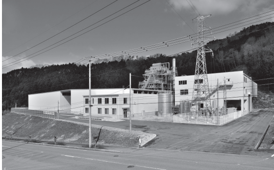
真庭バイオマス発電所
