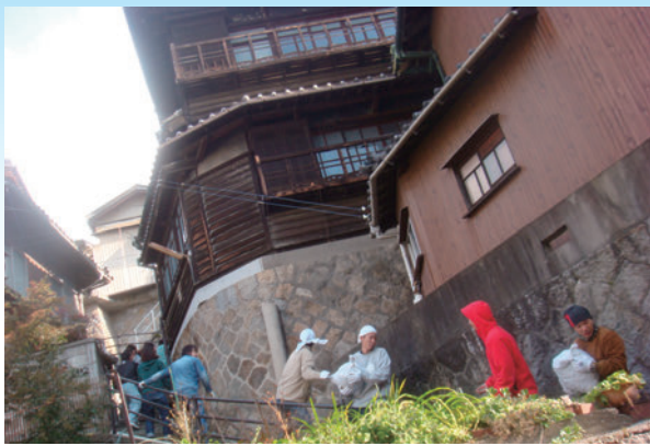
市民とともに進めてきた「ガウディハウス」の工事
