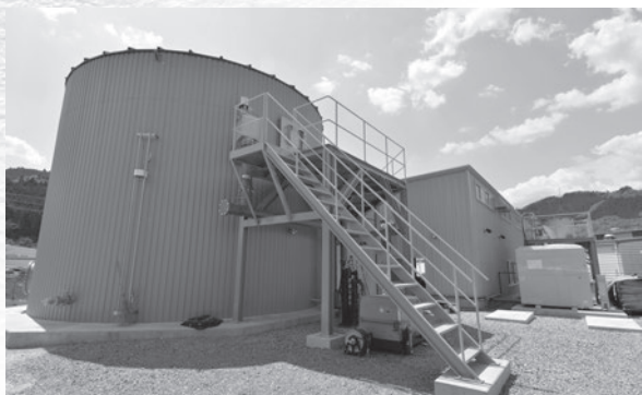
生ごみ処理施設実証プラント
