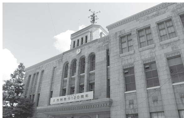
歴史的建築物として保存活用計画が進む1937年竣工の本庁舎
