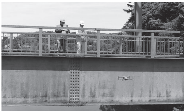
橋梁点検 岩の上橋
