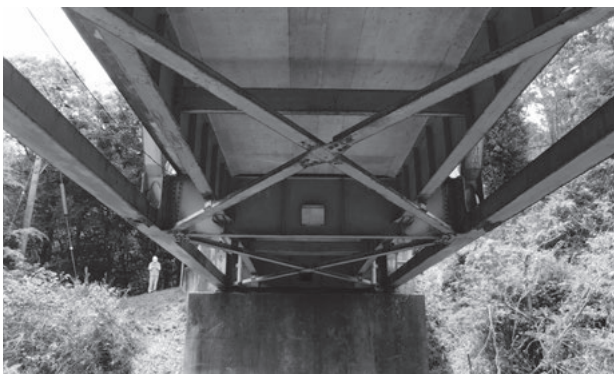
橋梁点検 滝原橋
