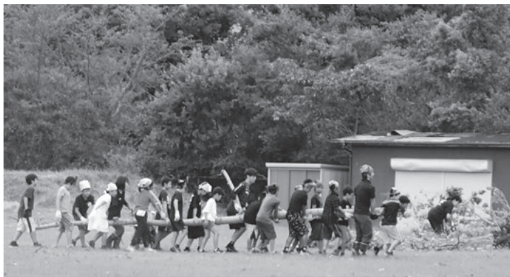
風水害を受けた小学校の倒木撤去作業
