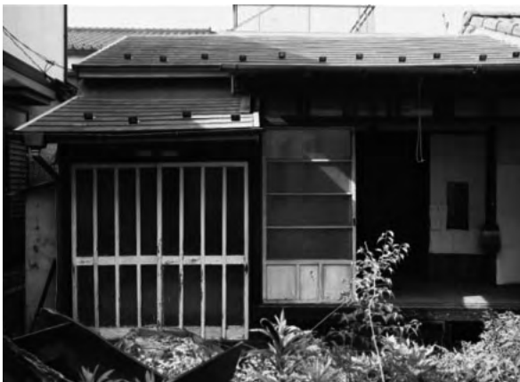
図1 改修前の蒲田の空き家
