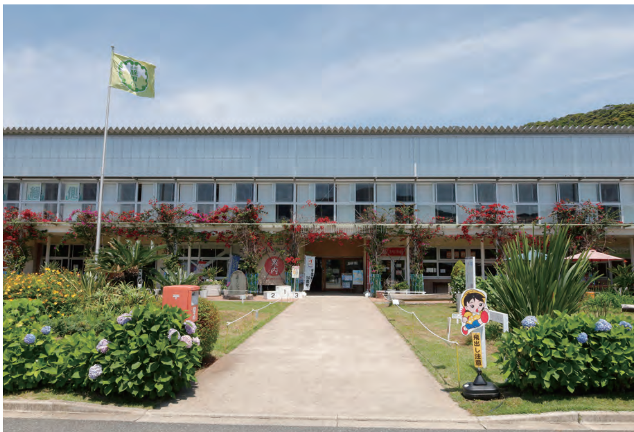
「道の駅 保田小学校」の正面外観。1階に食堂などの施設、2階に教室を利用した宿泊室が並ぶ
