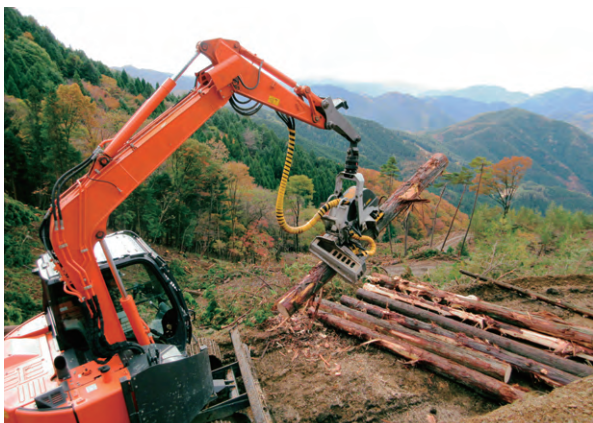
伐採作業には重機が導入されている（写真提供：西栗倉百年の森林協同組合）
